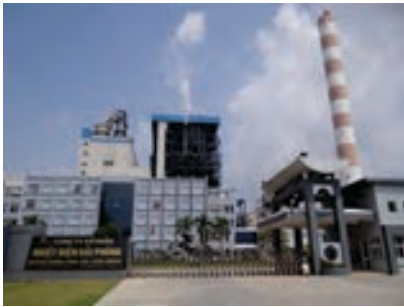
Hai Phong thermal power plant Nhà máy nhiệt điện Hải Phòng
